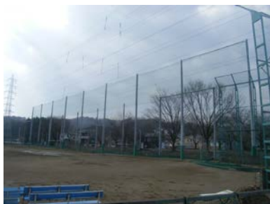
野球場防球ネット工事
