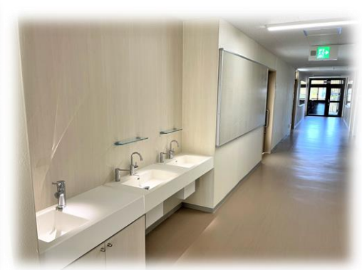
(廊下に新設した手洗いスペース)
